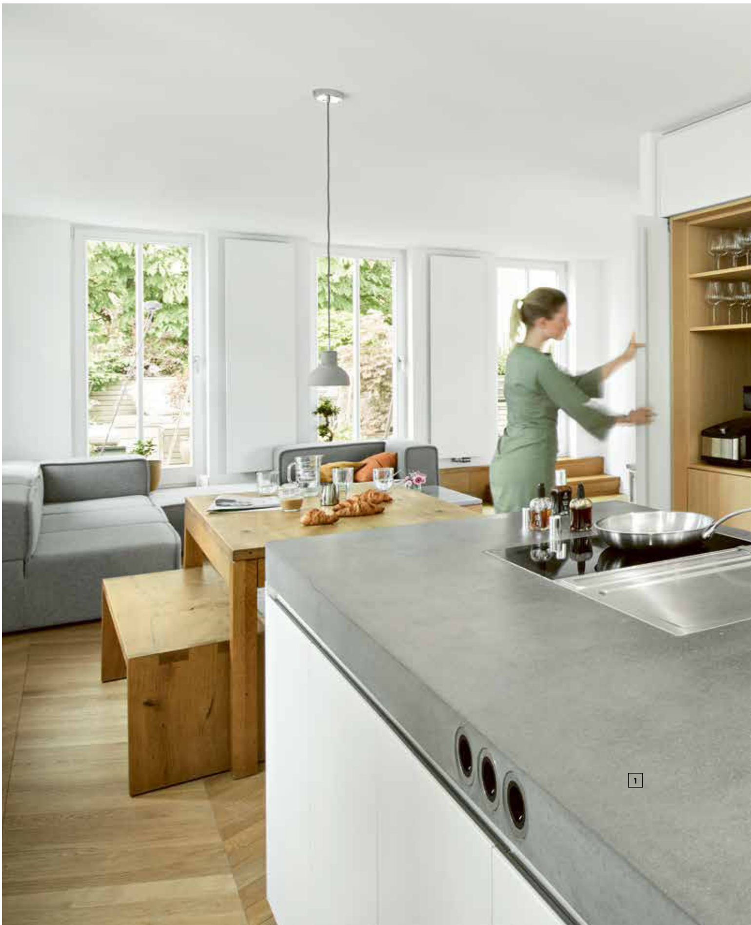
1 Beton, von einem Spezialbetrieb gegossen, poliert und mit Schutzlasur eingelassen. Er wird mit der Zeit eine schöne Patina entwickeln.
