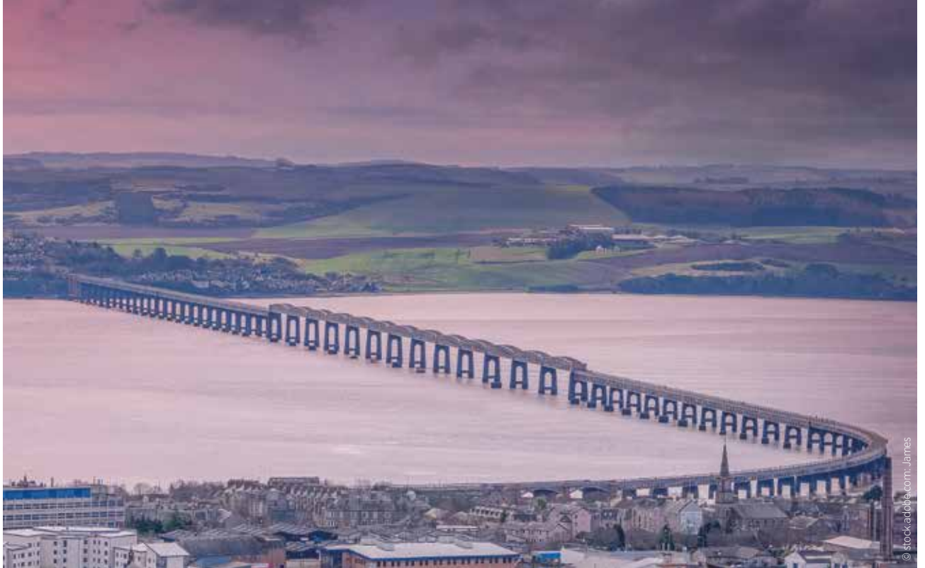
1887 wurde die neue Firth of Tay Bridge fertiggestellt und ist bis heute im Einsatz. Vor 20 Jahren musste sie von Grund auf saniert werden – hunderttausende Nieten wurden ersetzt
